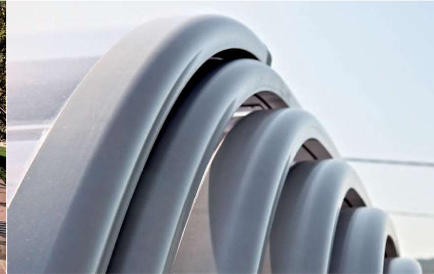
DER EINSATZ VON MODERNEN, COMPUTERGESTEUERTEN BIEGEANLAGEN ERMÖGLICHT DIE MASSGENAUE ANFERTIGUNG VON WECHSELNDEN BÖGEN BEI DEN ÜBERDACHUNGEN. DIE ÜBERDACHUNGEN MIT KORBBOGENFORM HABEN DURCH DIE VORTEILHAFTEN STATISCHEN EIGENSCHAFTEN DER GEBOGENEN STRUKTUREN MIT SCHWUNGVOLLEN FORMEN, DIE AUSWAHL BEREICHERT.
