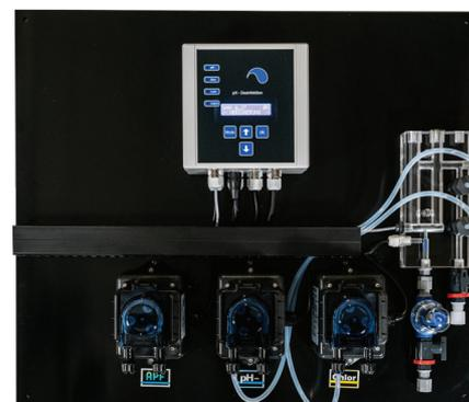
avec 3 pompes doseuses, correction pH, oxydation et APF®
